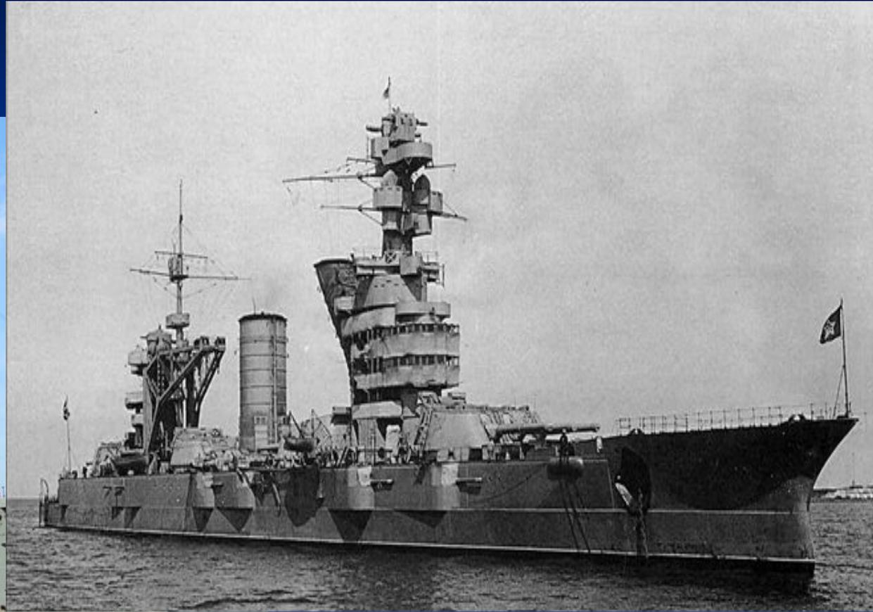
Линкор – плавающая морская крепость. Линкор был оснащен крупнейшими орудиями, помещенными в особые вращающиеся башни. Орудия стреляли на расстояния более 50 км. Команда составляла 1400 человек
