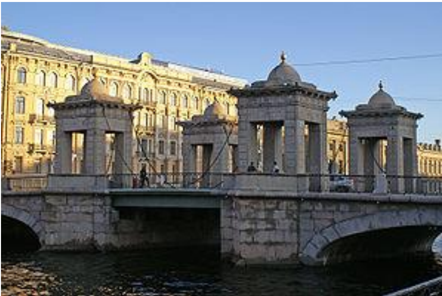
Мост Ломоносова через Фонтанку. Санкт-Петербург
