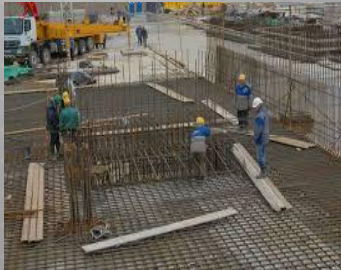
Фундамент плиталарын бетондау
