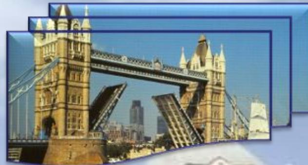
**Нижний ярус расположен на высоте 9 метров над уровнем воды и во время прохождения крупных судов он разводится. Он разводится очень быстро всего за полторы минуты, при этом его части поднимаются почти на 90 градусов.**
