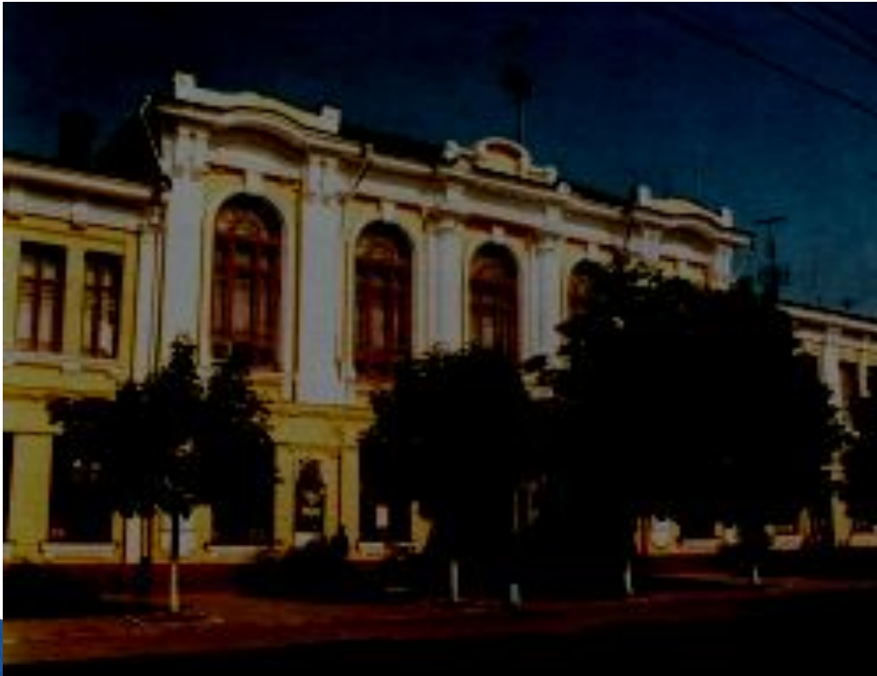
La maison des officiers
