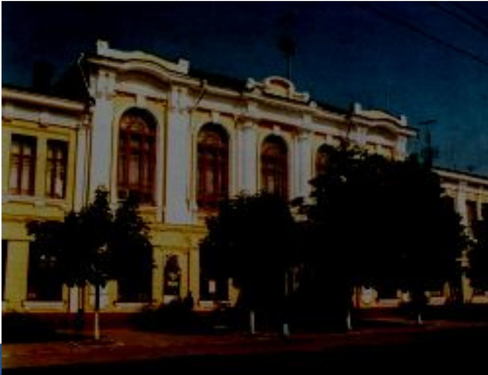
La maison des officiers
