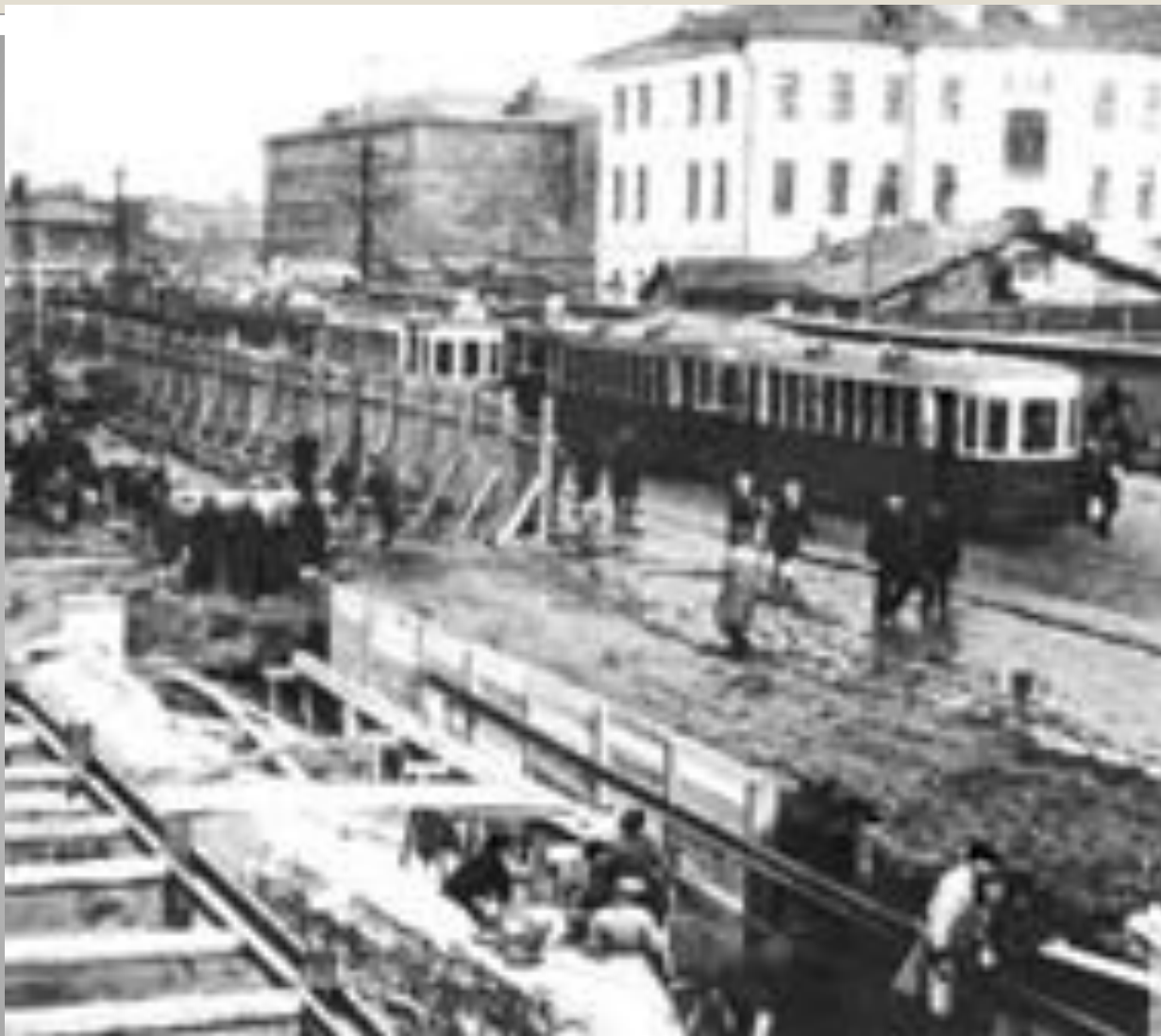
СТРОИТЕЛЬСТВО ПЕРВОЙ ЛИНИИ МЕТРО
