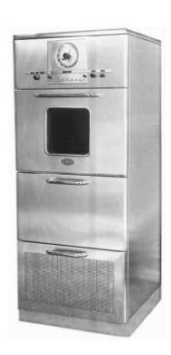
ITS HEIGHT WAS APPROXIMATELY EQUAL TO HUMAN'S HEIGHT, WEIGHT 340 KG, POWER - 3 KW, WHICH IS ABOUT TWICE THE POWER OF MODERN HOUSEHOLD MICROWAVE OVEN. IN 1949 IT WAS STARTED ITS SERIAL PRODUCTION. THE PRICE OF THE MICROWAVE WAS \$ 3,000.
