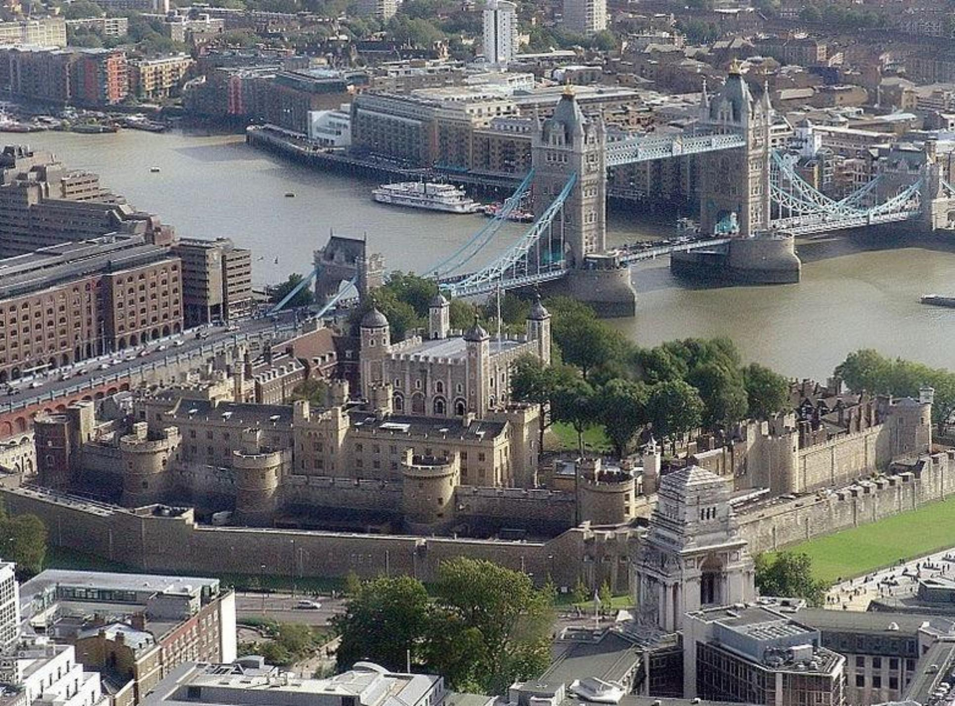
**Мост** имеет общую длину 244 метра, посередине находятся две башни, каждая высотой 65 метров. Полное разведение моста при подъеме каждого крыла под углом до 83 градусов занимает меньше двух минут.
