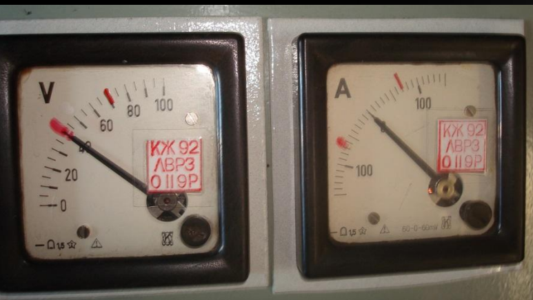
Электроизмерительные приборы вагона производства КВЗ
