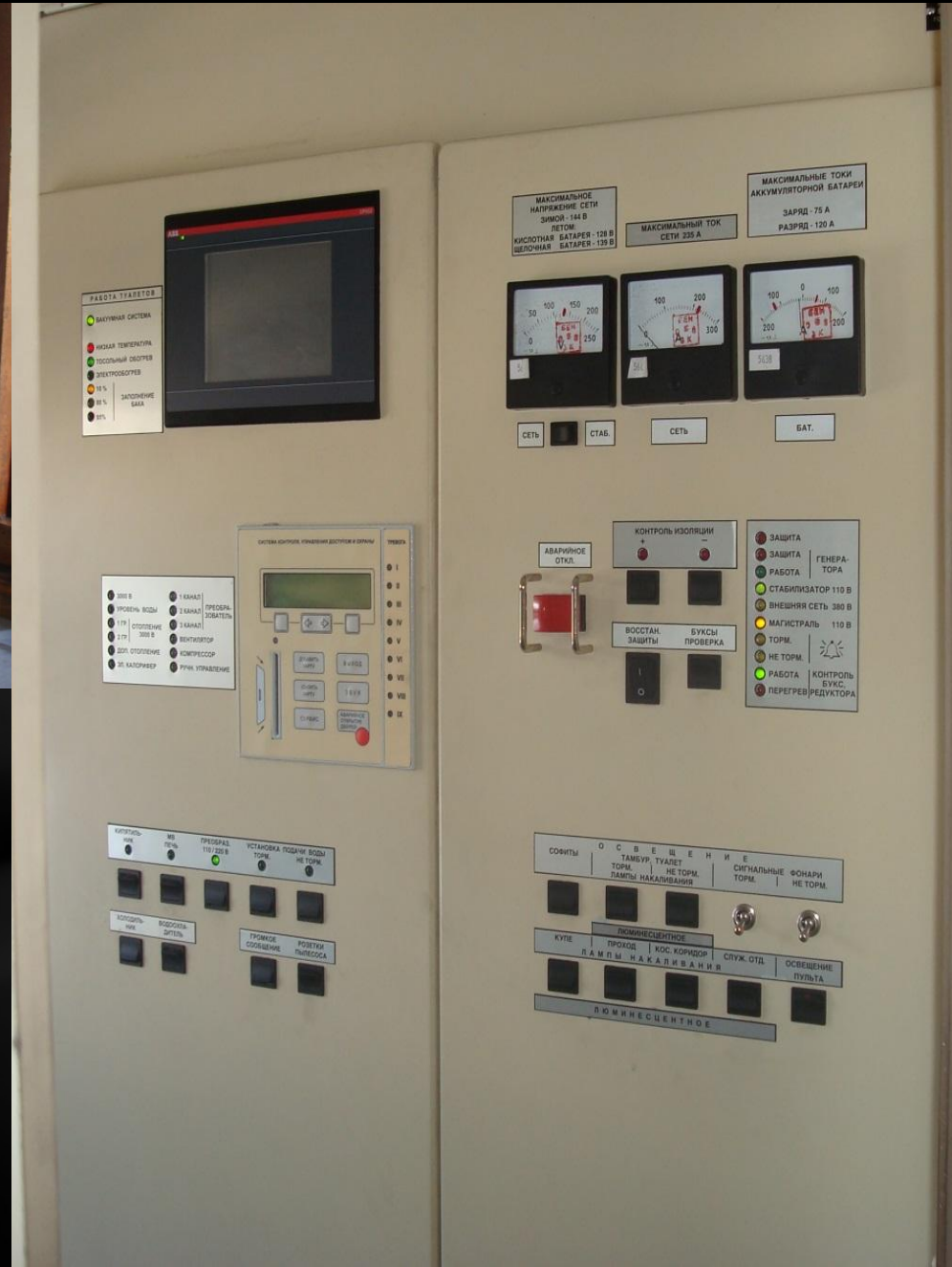
Электрощит купейного вагона 110В производства ТВЗ
