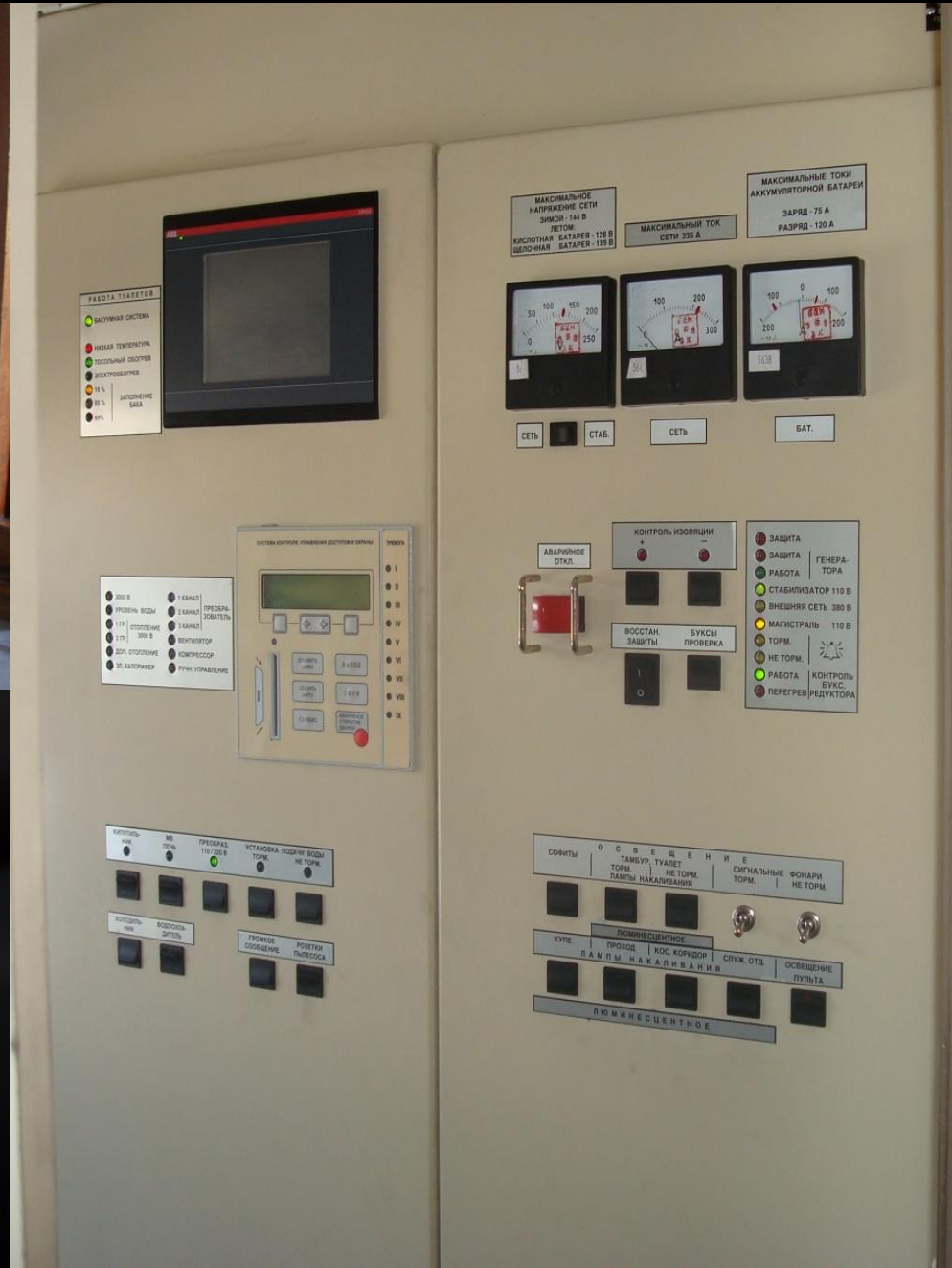
Электрощит купейного вагона 110В производства ТВЗ
