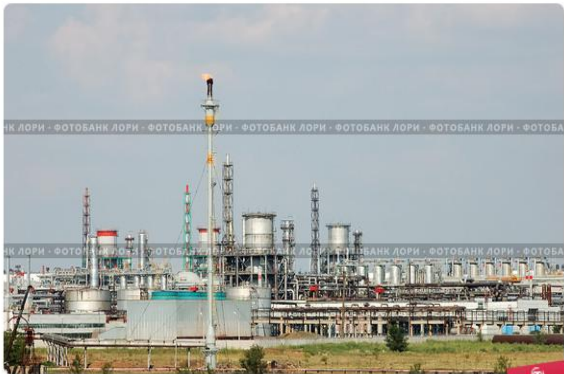
Оренбургский газоперерабатывающий завод
