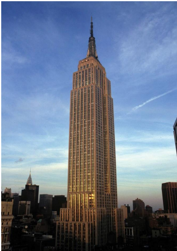
Емпайр-стейт (Empire State Building)
