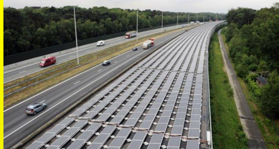
Тоннель с солнечными батареями
