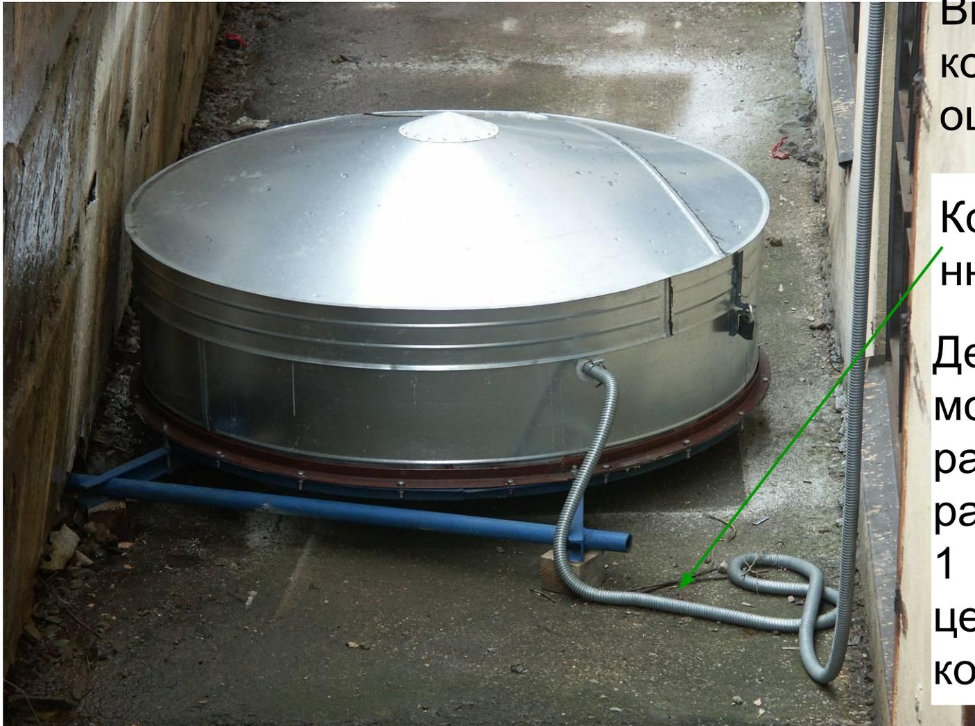
Внешний корпус – 0.7 мм оцинковка
