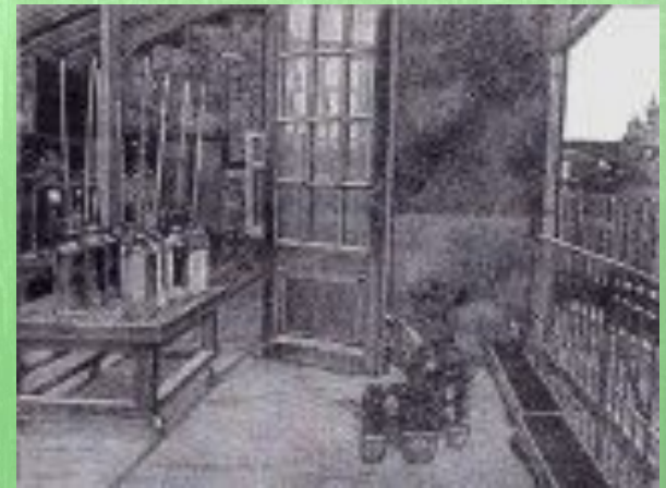
Уголок теплицы на крыше Московского университета, построенной по проекту К. А. Тимирязева.
