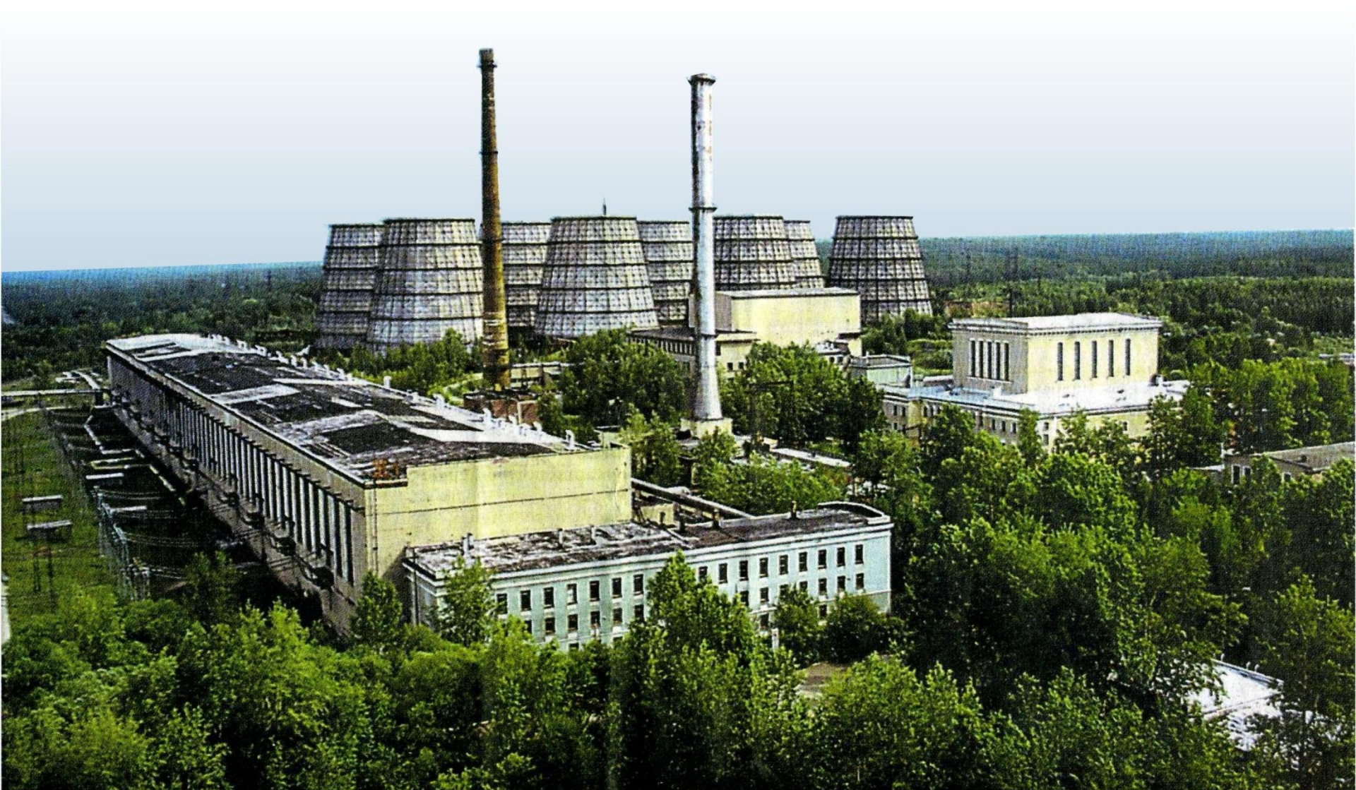
Рис...Внешний вид атомной электростанции, г. Северск, Томская обл.
