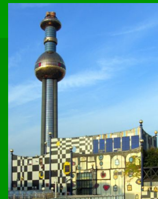
Мусоросжигательный завод в Вене
