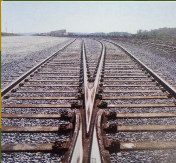
Рис. 3. Путь на стальных шпалах компании NARSTCO
