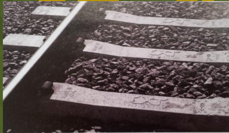
Рис. 1. Путь на железобетонных шпалах компании СХТ
