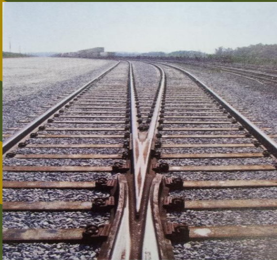
Рис. 3. Путь на стальных шпалах компании NARSTCO
