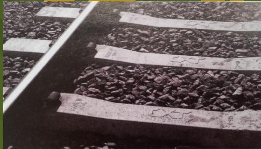
Рис. 1. Путь на железобетонных шпалах компании СХТ
