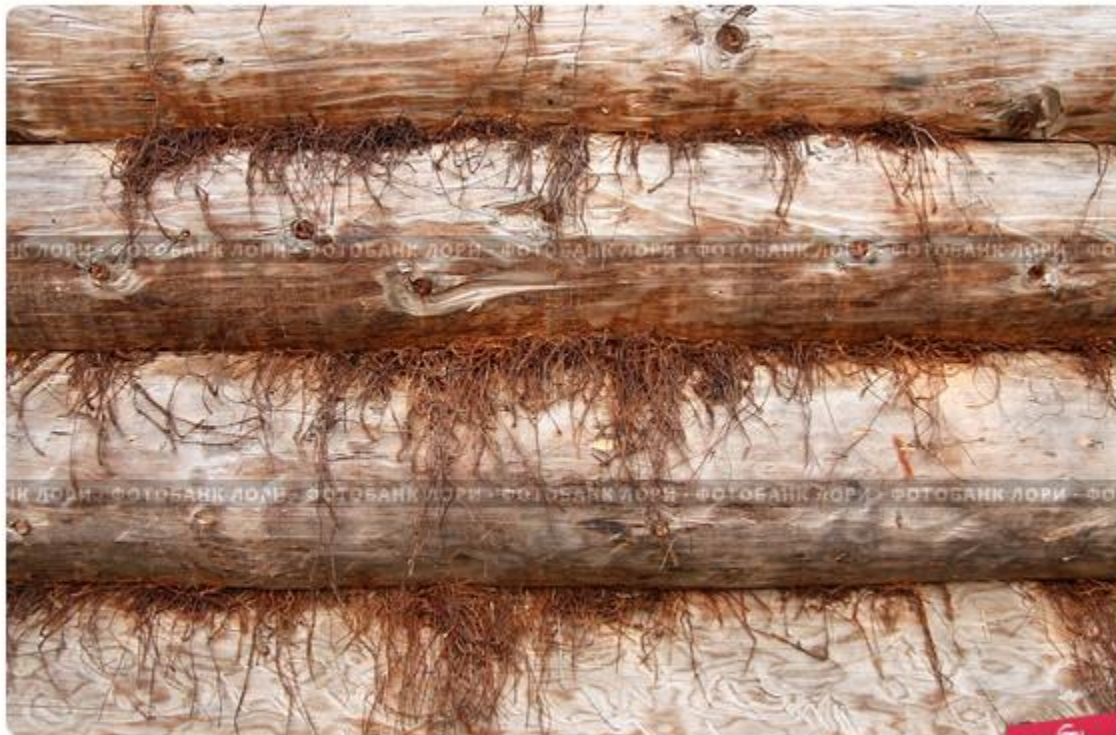
Стена бревенчатого дома с прокладкой из мха "кукушкин лен". Фон. © Галина Бурцева / Фотобанк Лори
