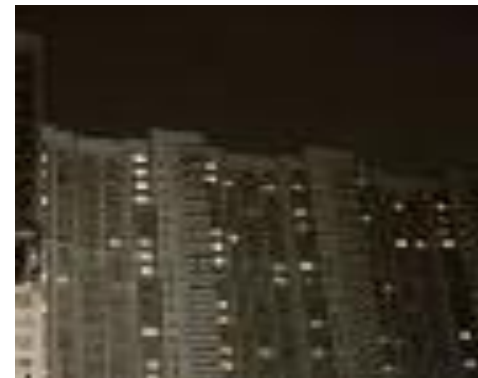
Многоквартирный высотный дом
