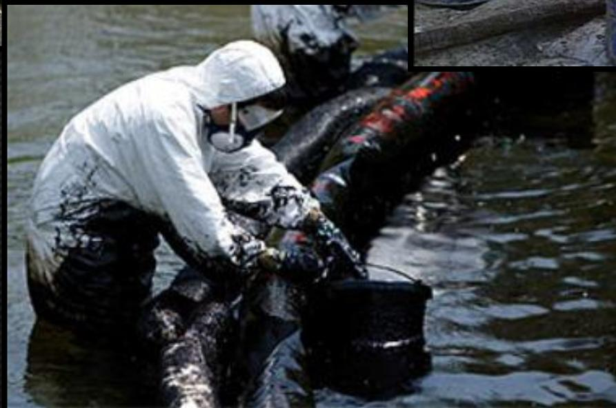
Механическое удаление нефти с поверхности
