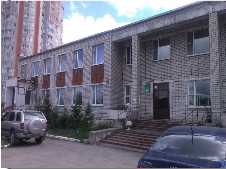
Поселок Залесный, ул.Хибинская, д.16
