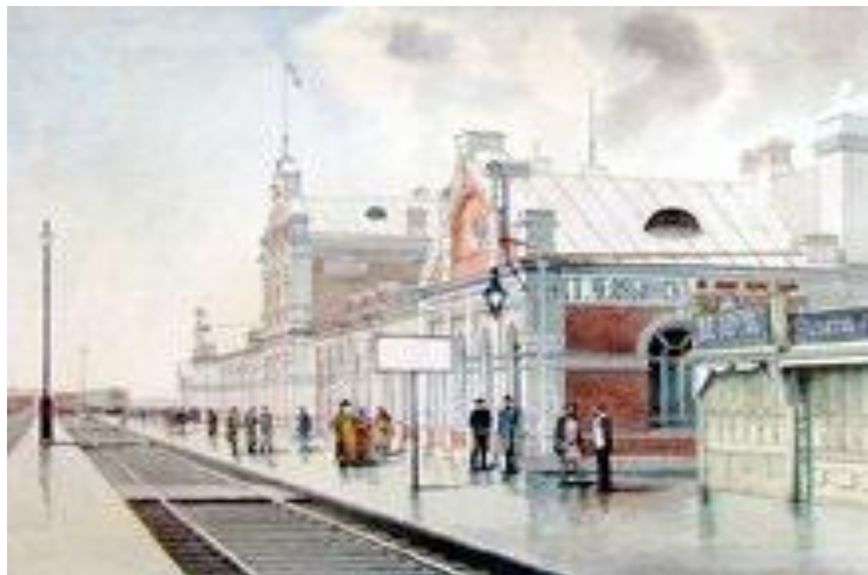
Здание вокзала 1892 г.
