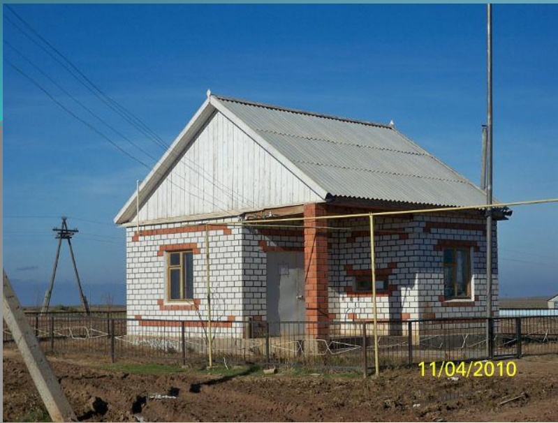
Здание для очистки воды
