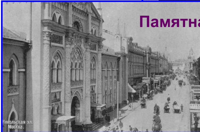
Здание бывшей Синодальной типографии
