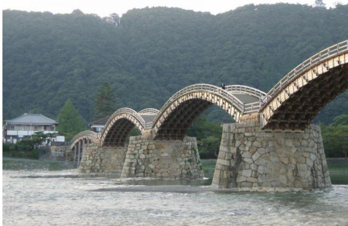
Мост Кинтай, Япония. Построенный в 1673, этот деревянный арочный мост проложен через реку Нишики, Япония. Нынешний мост является последним в серии деревянных мостов, которые были разрушены внезапными наводнениями. Благодаря архитектурным улучшениям, эта окончательная версия моста до сих пор стоит и была названа японским правительством национальным достоянием страны.
