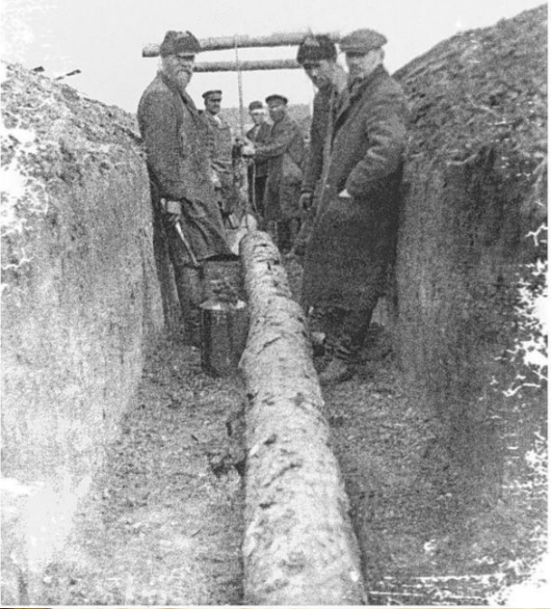
УКЛАДКА ВОДОВОДА ИЗ ДЕРЕВЯННЫХ ТРУБ 1932 г.
