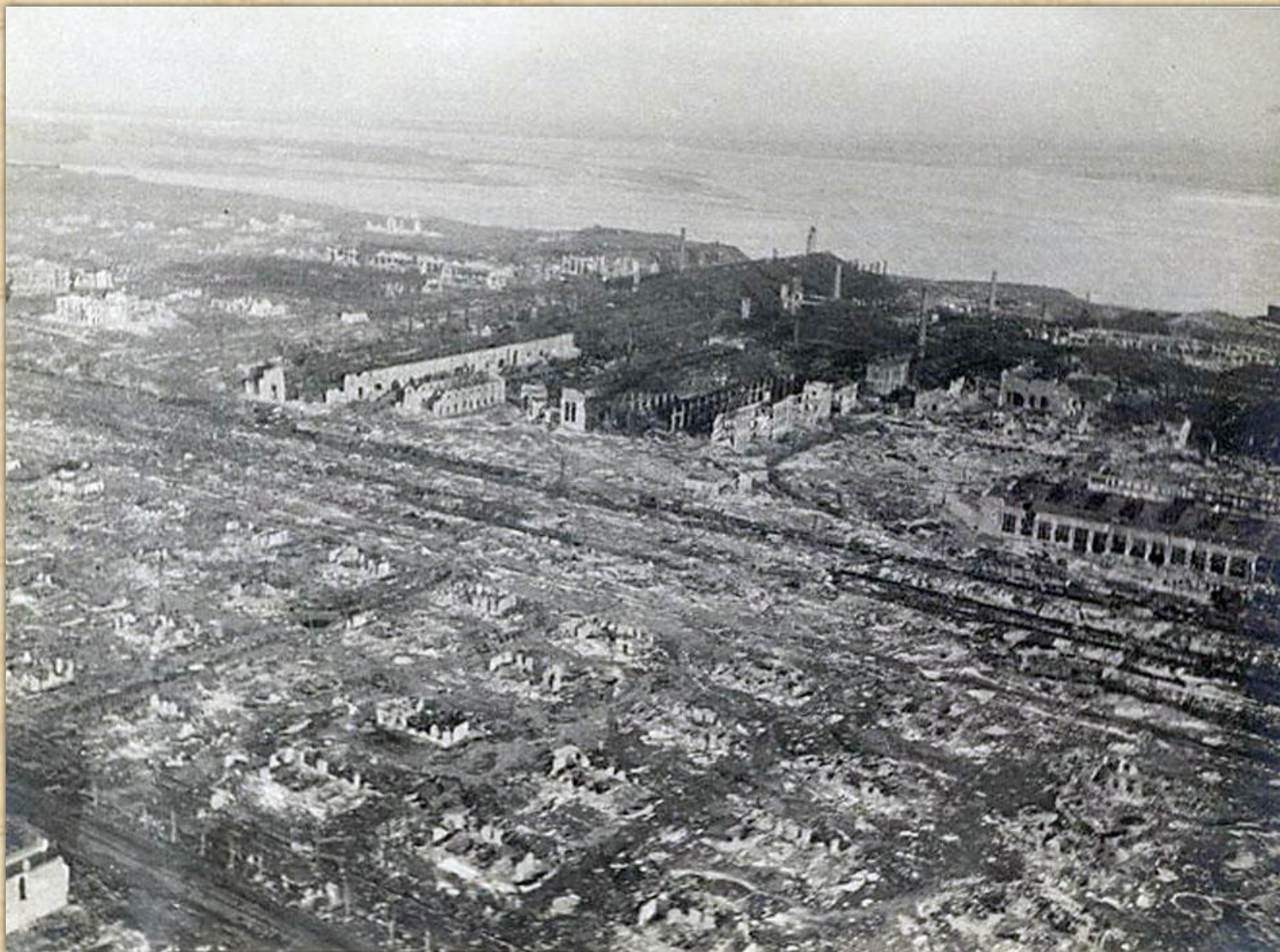
Разрушенные кварталы города.
