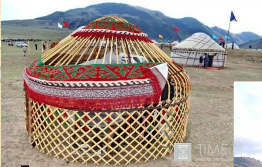
При установке юрты, вначале ставится дверной косяк и навешивается дверь, затем устанавливаются деревянные решетки (**кереге**), составляющие стены. **Тюндюк** (деревянный круг в верхней части юрты) соединяется с кереге длинными изогнутыми жердями. Затем кереге обтягивается орнаментированным войлоком, циновками и покрывается кусками войлока различной формы и величины
