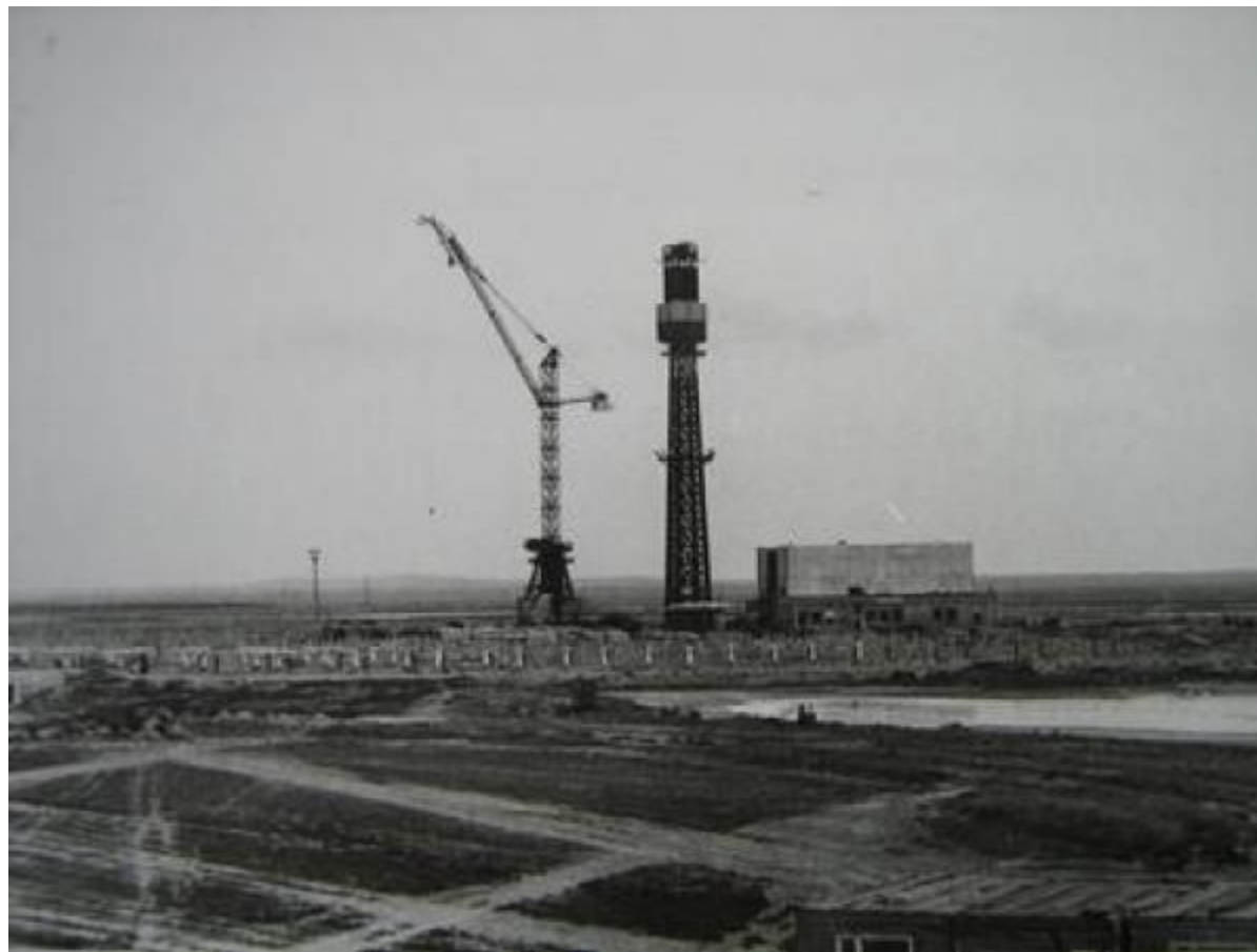
Первая советская солнечная электростанция.
