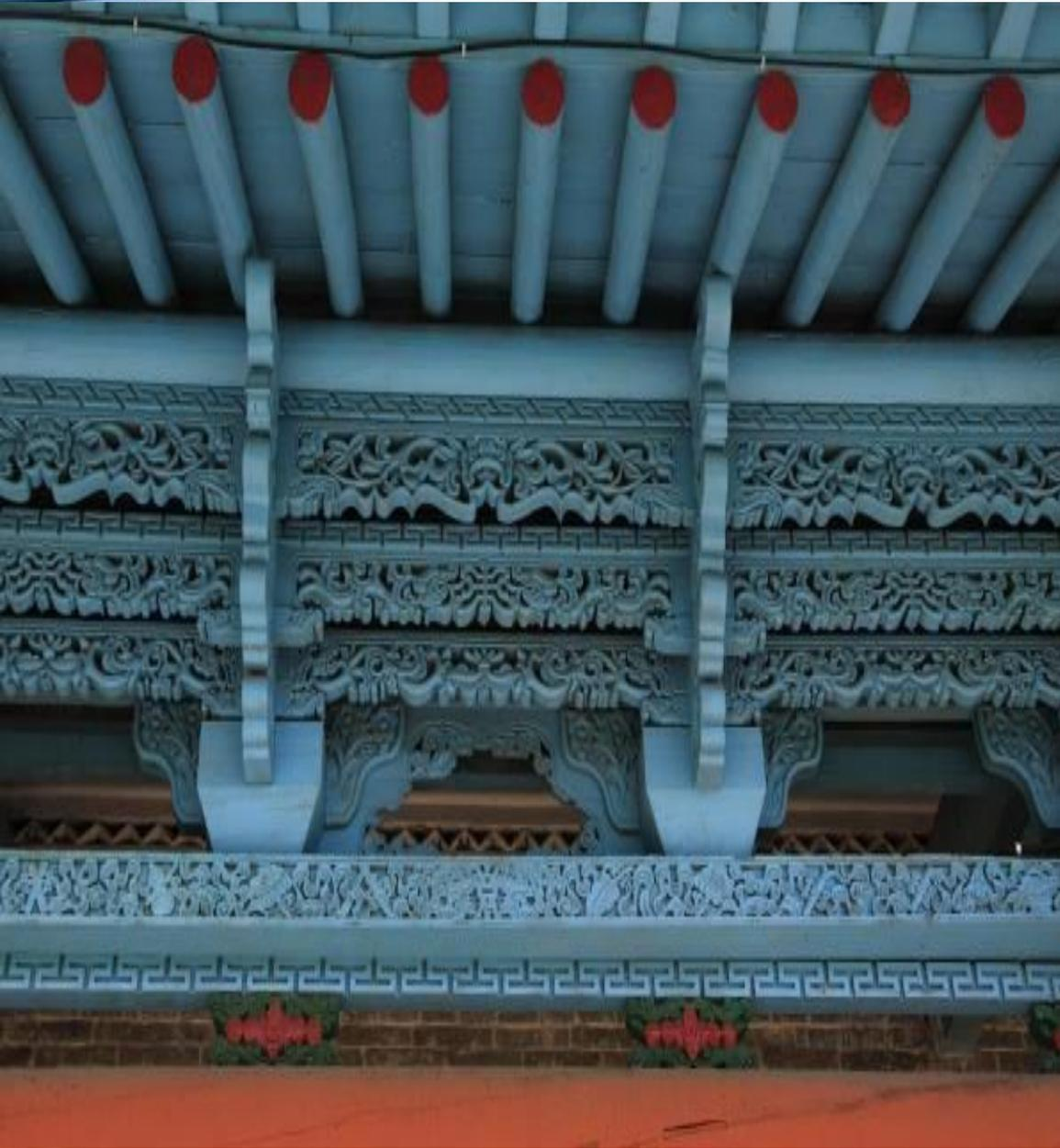
Уникальность мечети заключается в том, что она построена без единого гвоздя или каких-либо металлических связок. Опытные строители использовали лишь деревянные балки из тьянь-шаньской ели, карагача и местного тополя.
