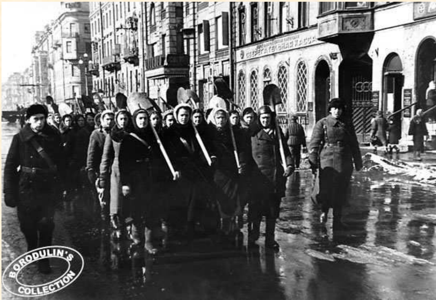
Женский строительный батальон
