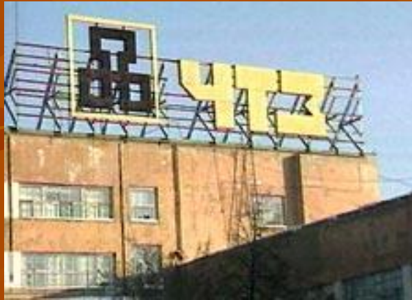
ООО «Челябинский Тракторный Завод»
