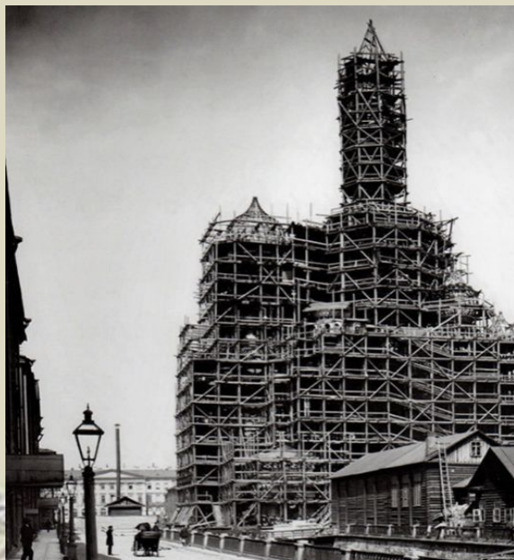
Строительство Храма Спас на крови
