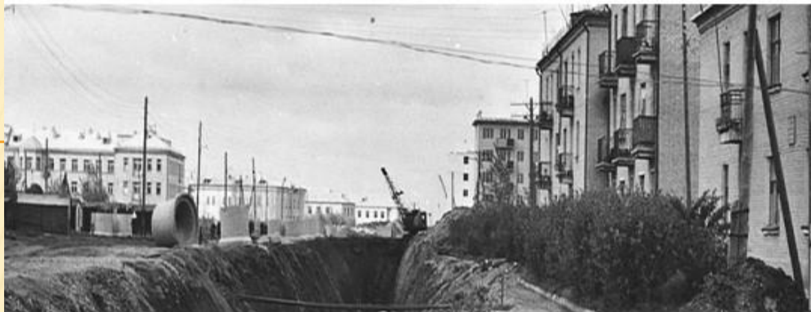
Прокладывают улицу Каменскую
