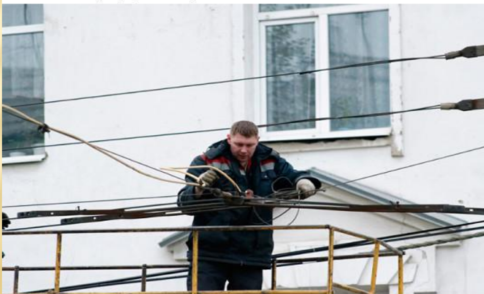
Демонтируется троллейбусная линия май 2015
