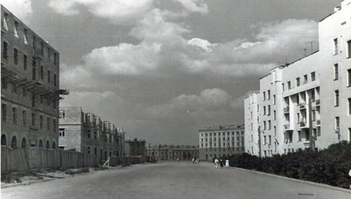
Еще строится дом с Детским Миром по Алюминиевой 1956-57 гг
