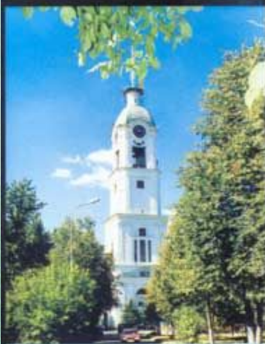
Колокольня Саровского монастыря. Вид с восточной стороны
