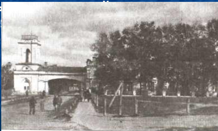
Здание бывшей Ильинской церкви, в которой с 1941 по 1968 гг. размещалась чулочно-трикотажная фабрика им. КИМ, эвакуированная из г. Витебска. Ульяновск, ул. Советская
