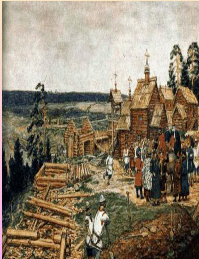
Строительство деревянного Кремля
