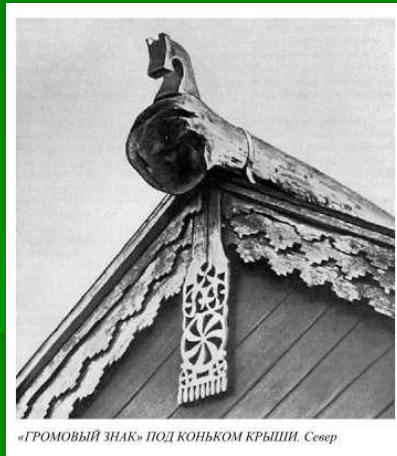
«ГРОМОВЫЙ ЗНАК» ПОД КОНЬКОМ КРЫШИ. Север
