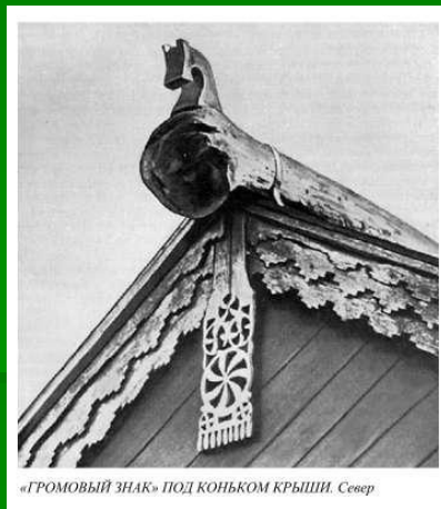
«ГРОМОВЫЙ ЗНАК» ПОД КОНЬКОМ КРЫШИ. Север
