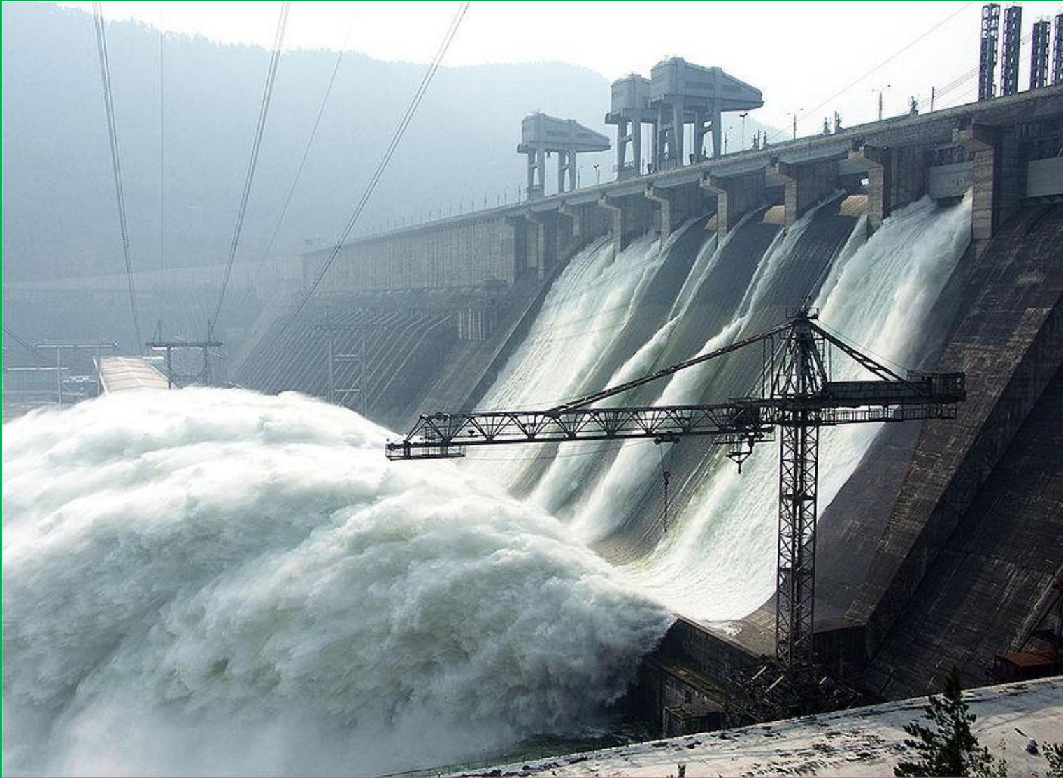
Строятся на больших полноводных реках. Вода с силой бьёт по лопастям турбины и заставляет её вращаться вместе с генератором.
