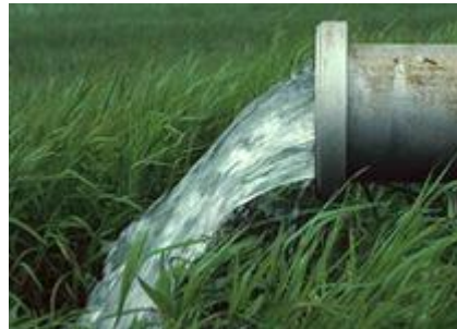
Очистка сточных вод
