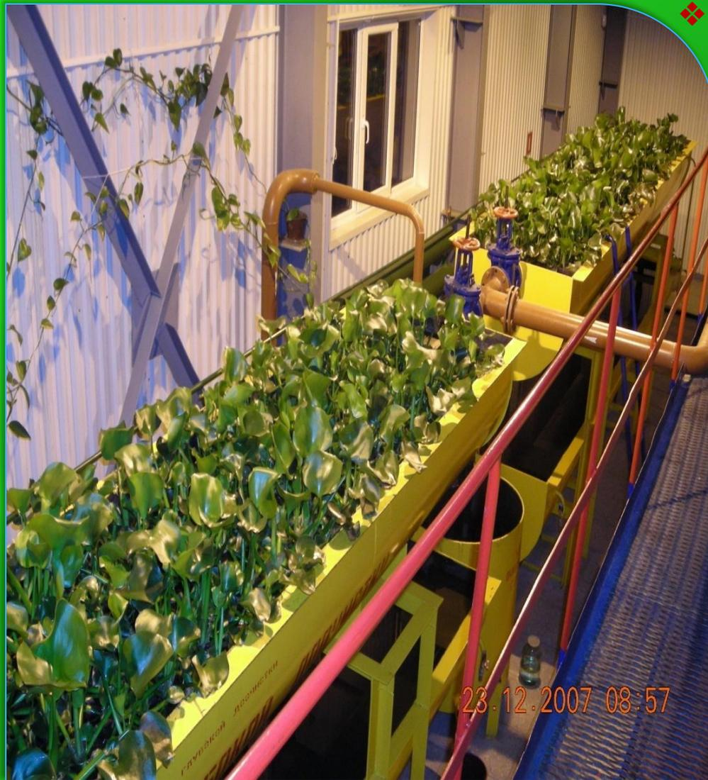
❖ Например: на предприятии Тюменьтрансгаза все промышленные отходы очищаются на специальных установках, в которых не применяются химикаты, а используют биологические способы очистки (бактерии, растения и ультрафиолет). Данный способ дает очистку
