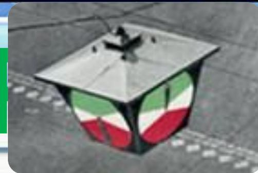
В тёмное время суток использовался газовый фонарь, с помощью которого подавались сигналы красного и зеленого цветов. Светофор использовался для облегчения перехода пешеходов через улицу, а его сигналы предназначались для транспортных средств — пока пешеходы идут, автомобили должны стоять.
