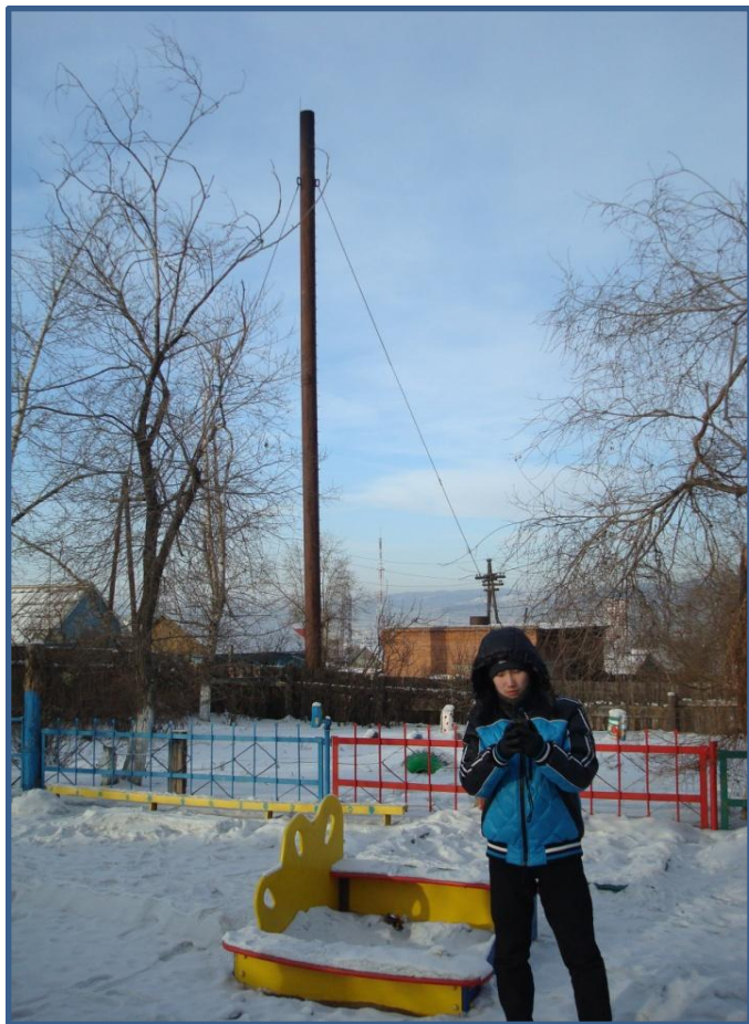
котельная Детского сада № 84 (мощность – 1,050 Гкал/ч)
