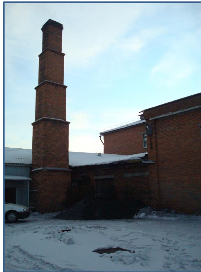
котельная Средней школы № 50 (мощность – 1,032 Гкал/ч)
