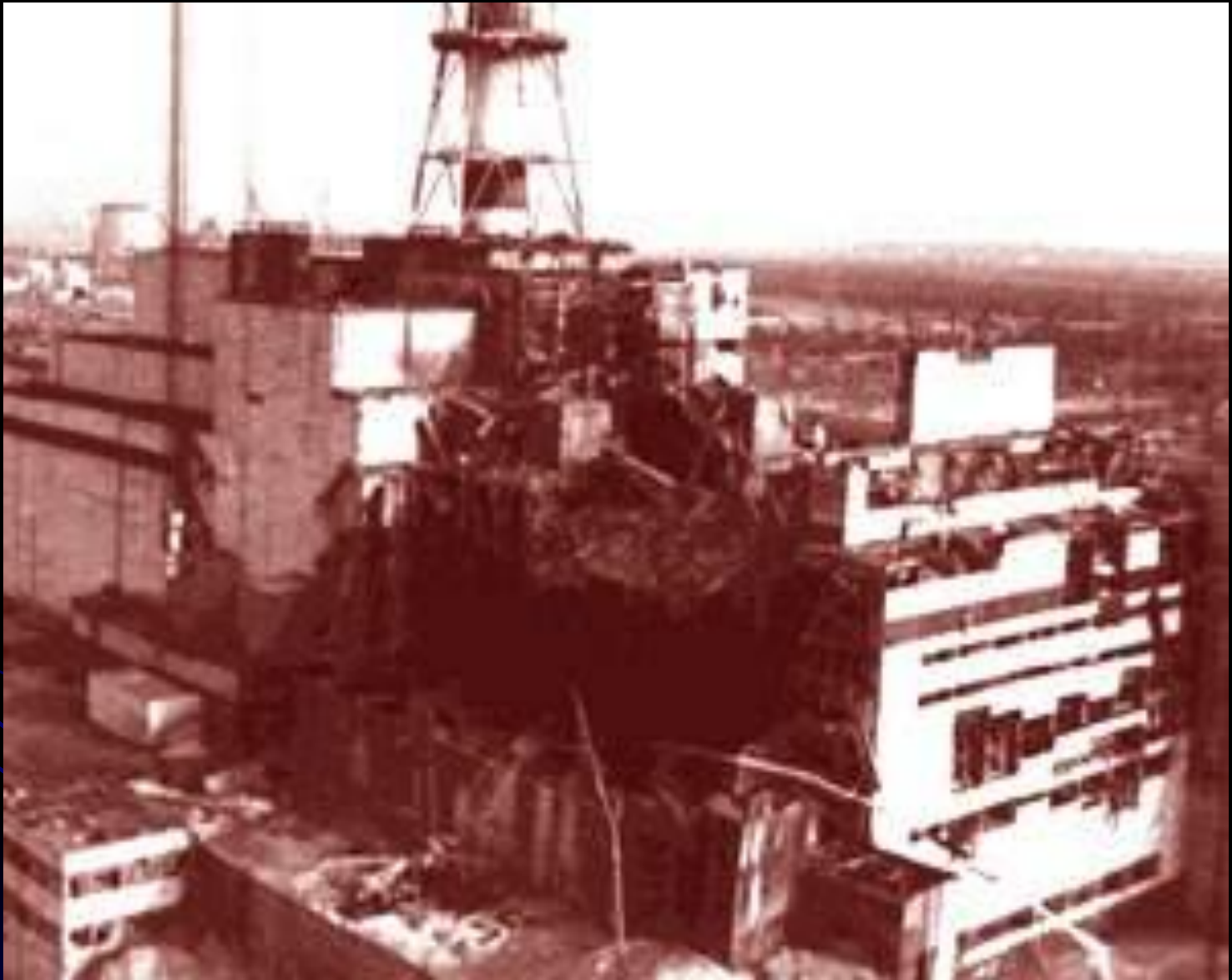
Разрушенный 4ый реактор АЭС
