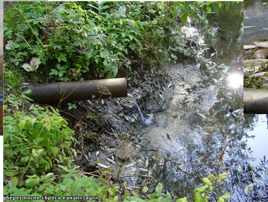
берег после сброса канализации
