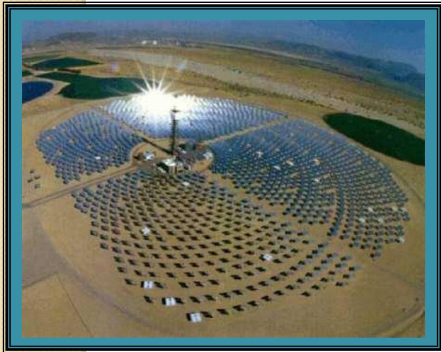
Солнечная электростанция (СЭС)
