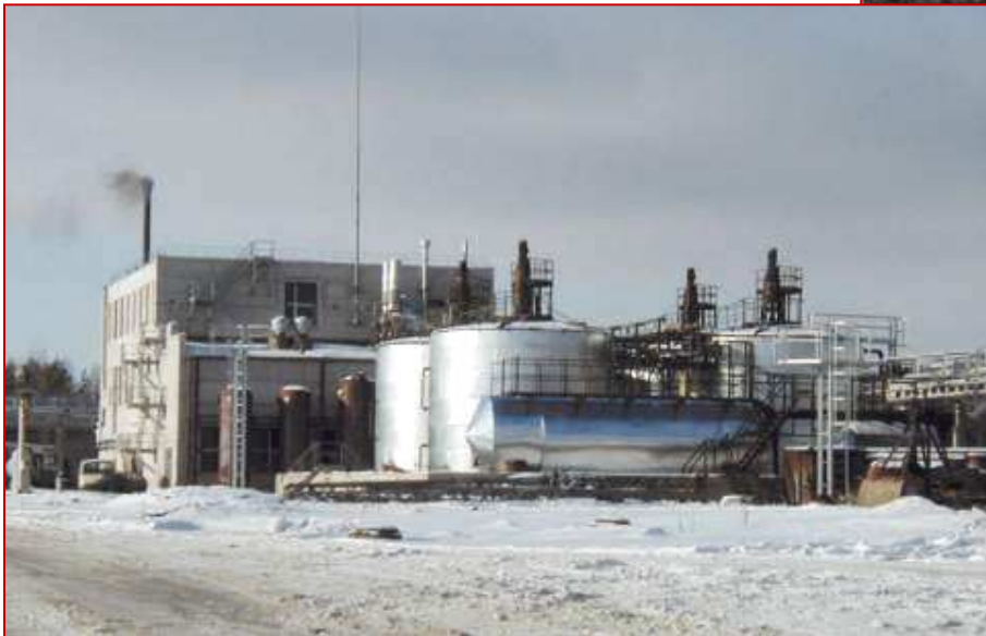
Корпус переработки жидких органических отходов на полигоне «Красный Бор»
