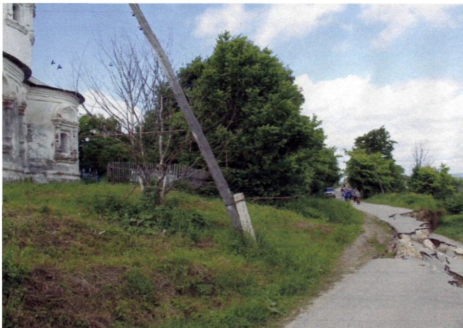
до проведения работ
