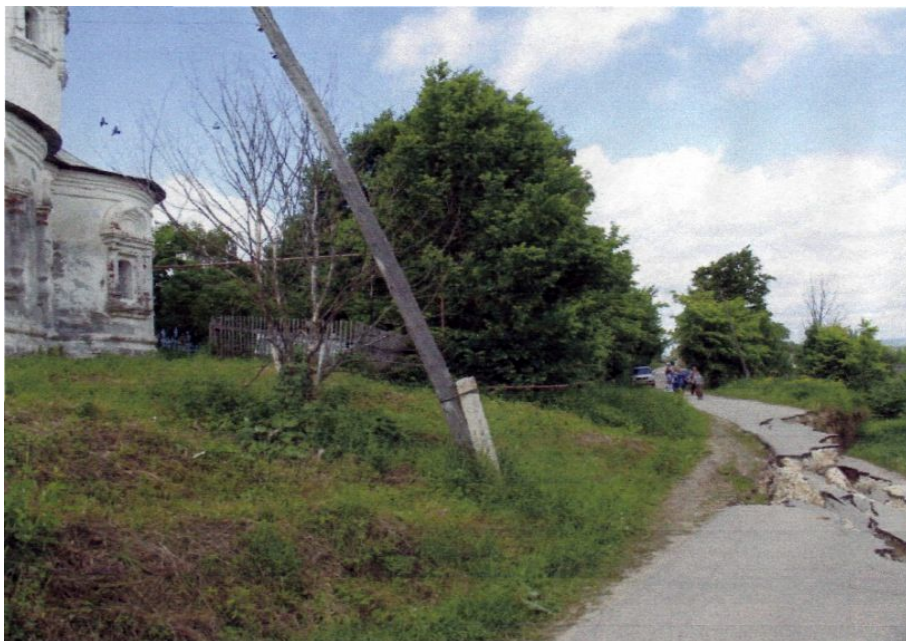
до проведения работ
