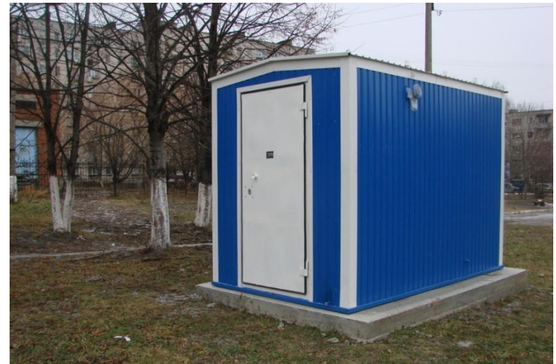
Автоматический стационарный пост наблюдения за состоянием атмосферного воздуха ( \text{CO} , \text{NO} , \text{NO}_2 , \text{H}_2\text{S} , \text{NH}_3 , \text{O}_3 , пыль)
