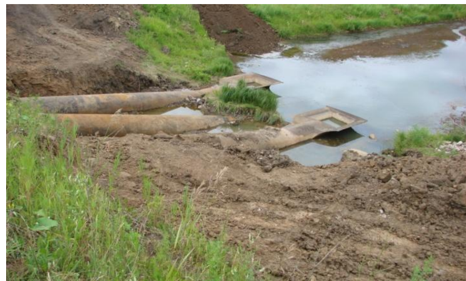
Разрушение гидроузла на р. Алешенка Рыбновского района
