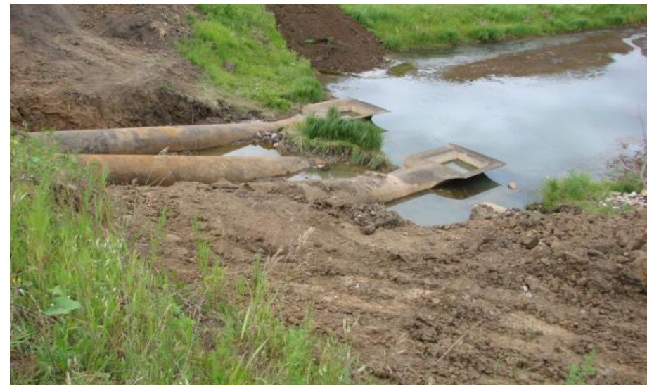
Разрушение гидроузла на р. Алешенка Рыбновского района
