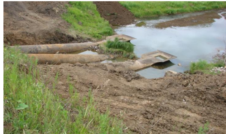
Разрушение гидроузла на р. Алешенка Рыбновского района
