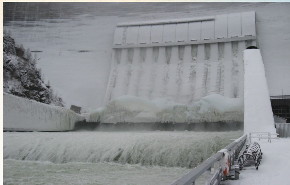
Водосброс. Январь 2010 года.
