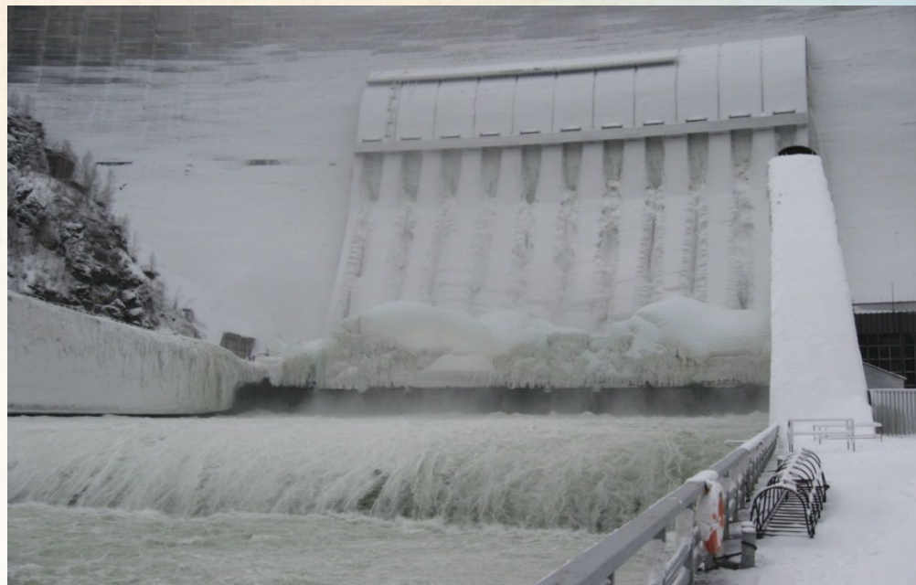
Водосброс. Январь 2010 года.
