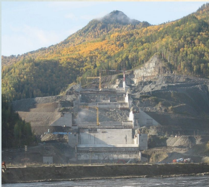
Береговой водосброс. Сентябрь 2008 года.
