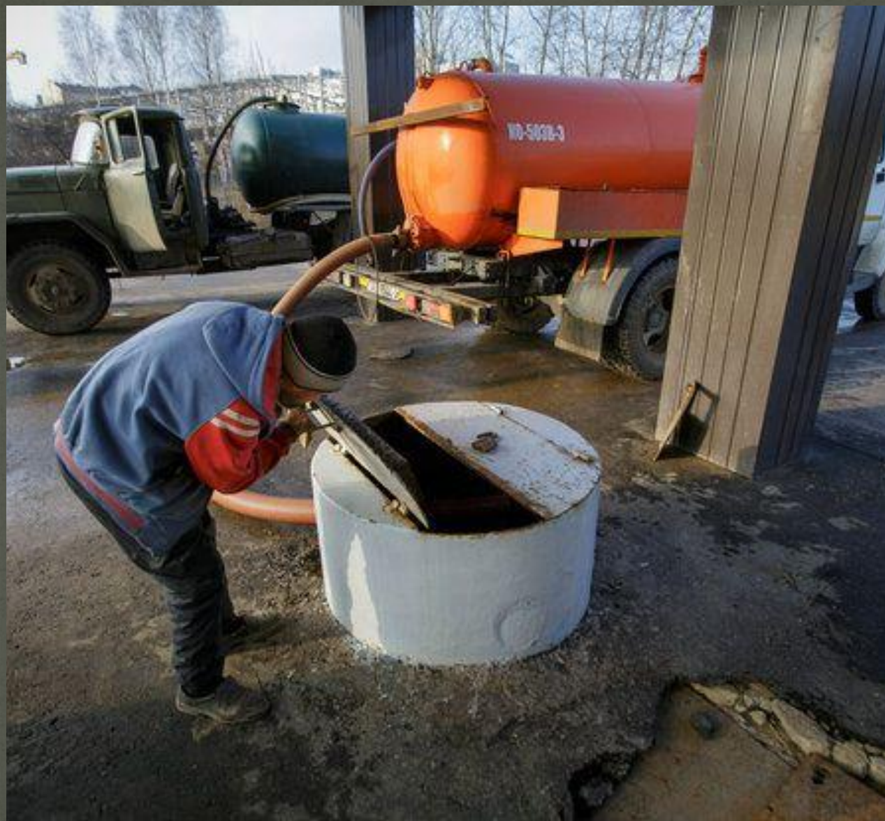
Откачка резервуаров на АЗС
