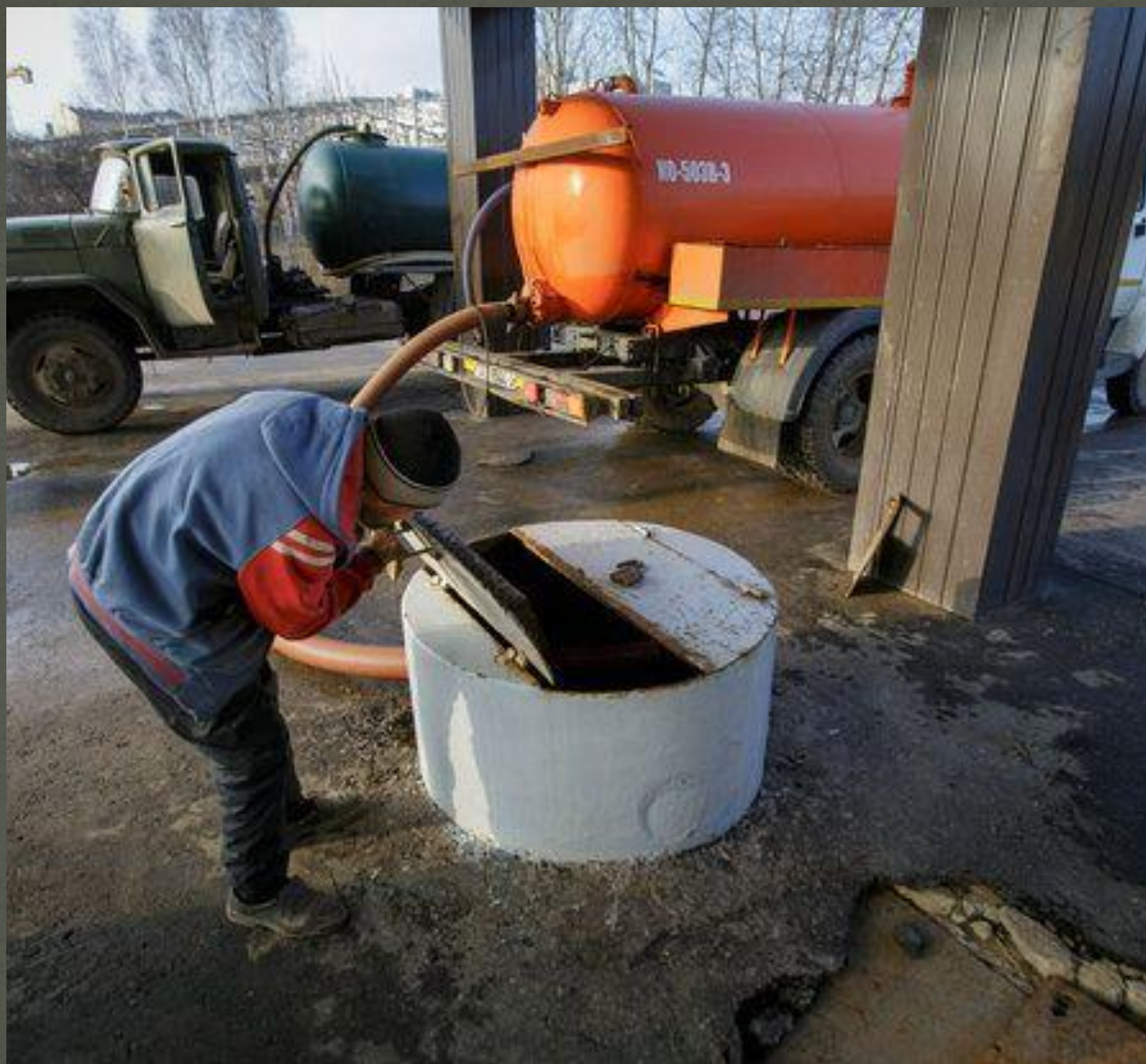
Откачка резервуаров на АЗС
